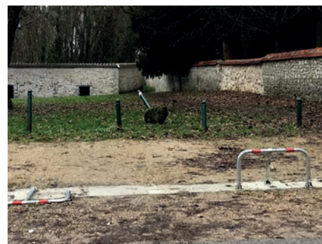
Le lavoir vu de l'avenue Foch, avec au premier plan, les nouvelles barrières
